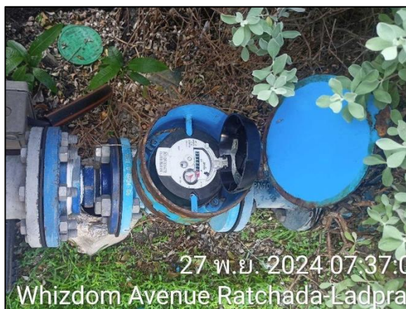
มิเตอร์รับน้ำจากการประปานครหลวง สาขาพญาไท
